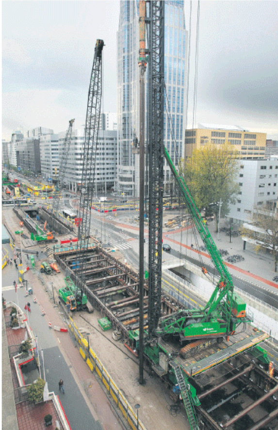
Rondom de Weenatunnel vinden veel activiteiten plaats die trillingen kunnen veroorzaken.
